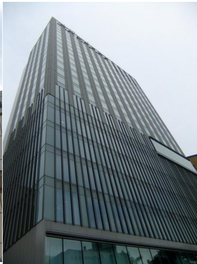
●仙台市内のPCカーテンウォールが採用された超高層建物の例
