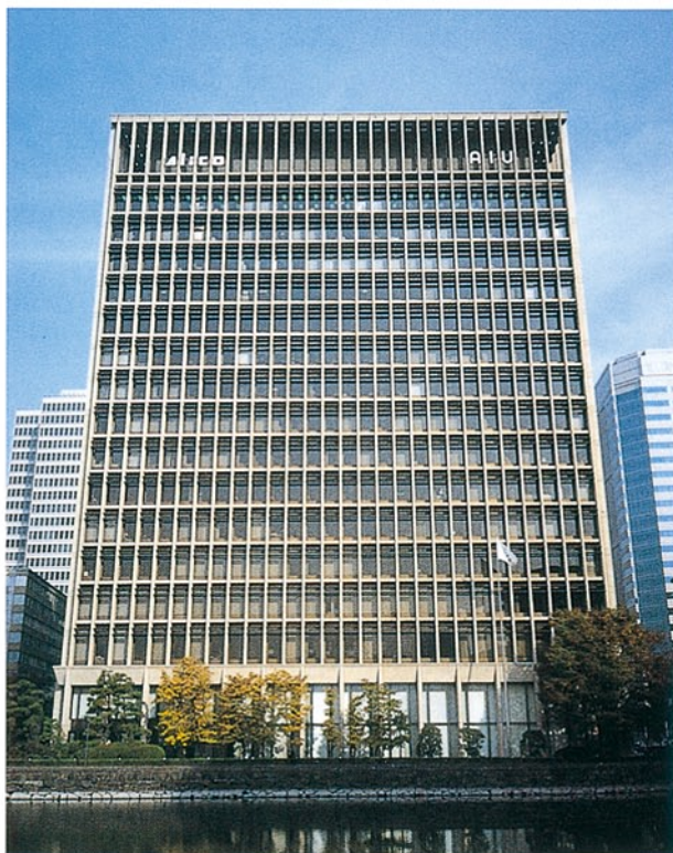
(写真5) 改修後のAIUビル
