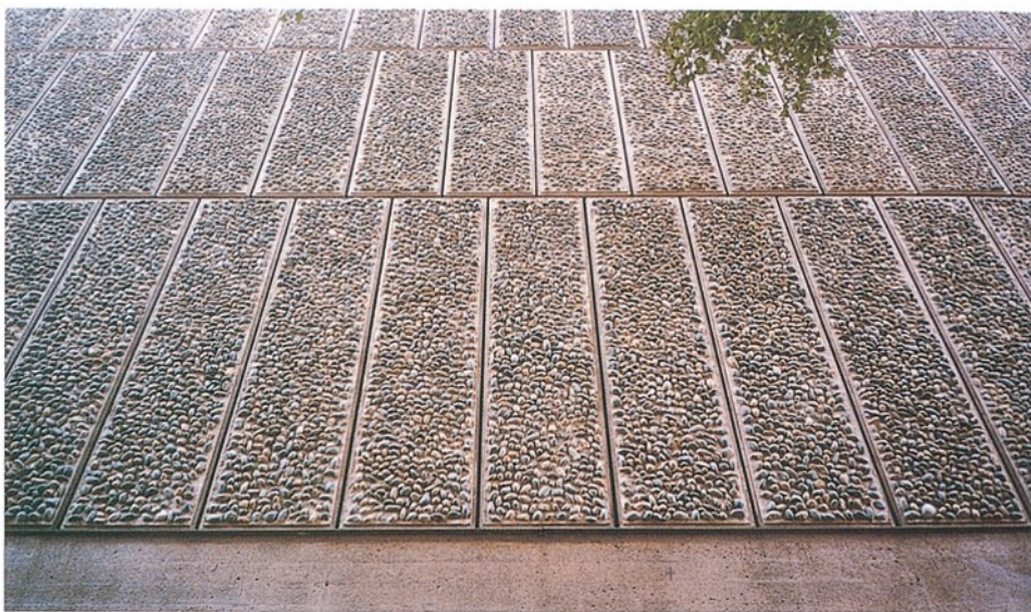
(写真3) 国立西洋美術館の再生された洗出しパネル
