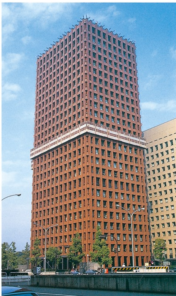
(写真6) 東京海上ビルの外壁改修の様子
