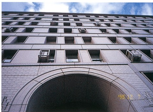
(写真7) GRCパネルで改修された後の丸ビル
