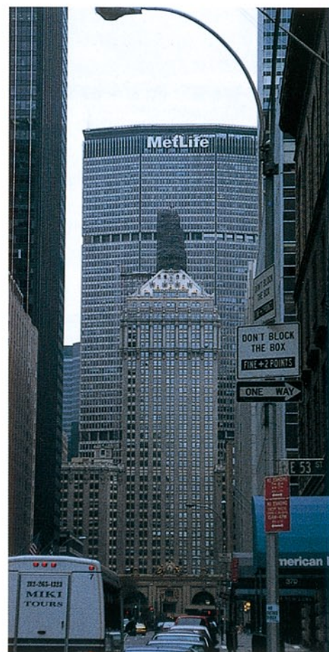
(写真10) パナムビル(現メットライフビル)
