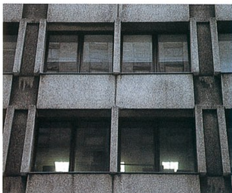
(写真9) パナムビルのPCカーテンウォール
