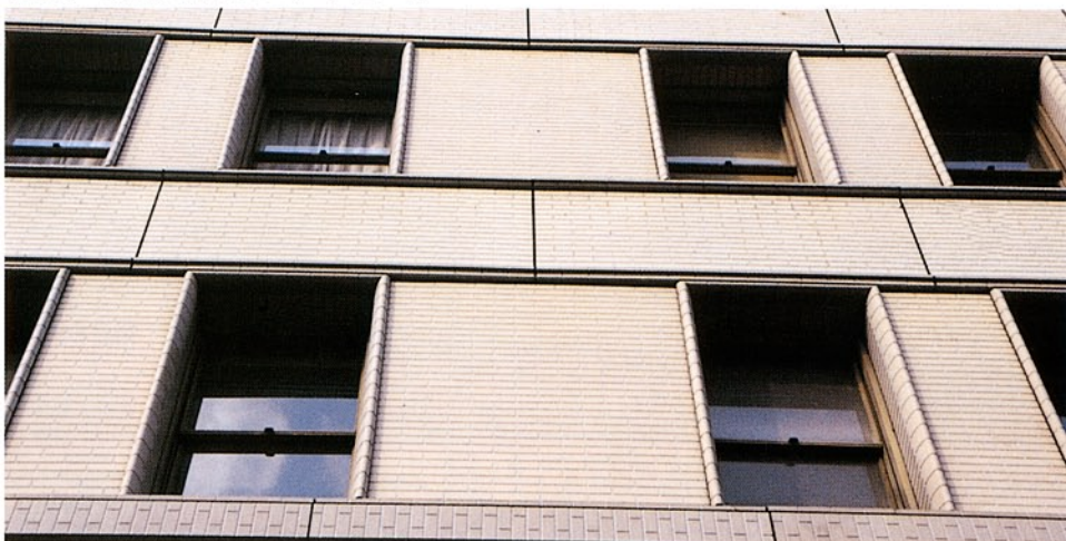
〈写真5〉 改修後の丸の内ビルディング(上・中)
