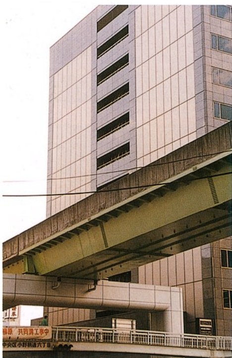
〈写真6〉 地震後にPCカーテンウォールから金属建材に改修された事例
