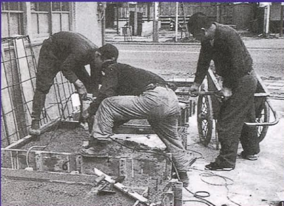
(写真3) 昔の製作風景 (湊建材工業株式会社)
